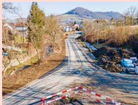
Sanierung und Erschliessung Zwidellen
