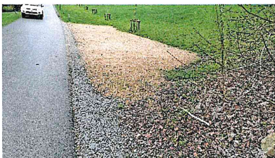
Ist-Zustand Parkplatz von oben
