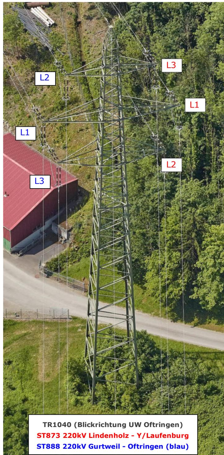
Abbildung 1: Aktuelle Phasenbelegung Mast TR1040x21
