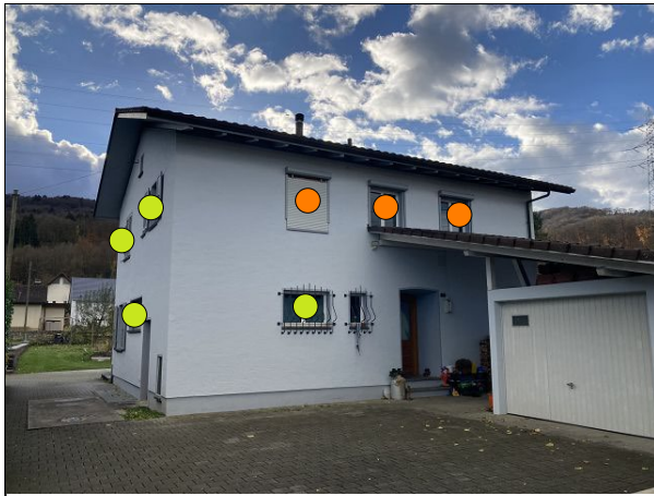
Ostfassade und Nordfassade
