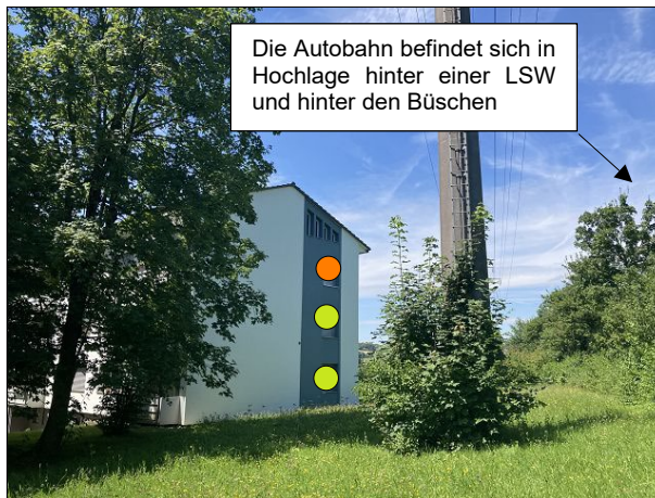
Südfassade (verdeckt) und Ostfassade
