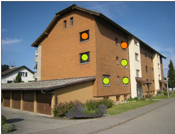
Haushälfte Kerbelweg 4: Südost- und Nordostfassade
