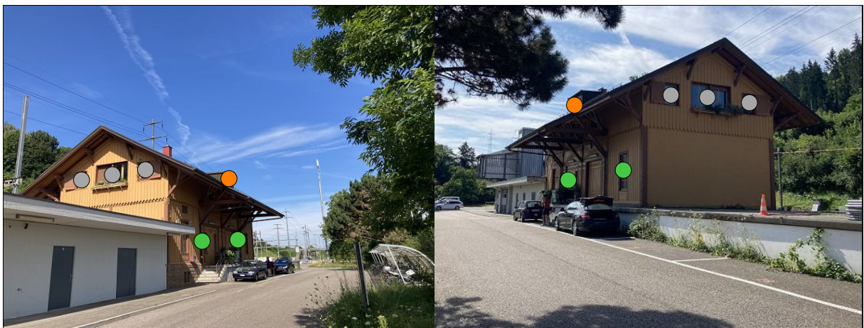
Ostfassade (n. beurteilt) u. Nordfassade (beurteilt) Nordfassade und Westfassade (nicht beurteilt)
