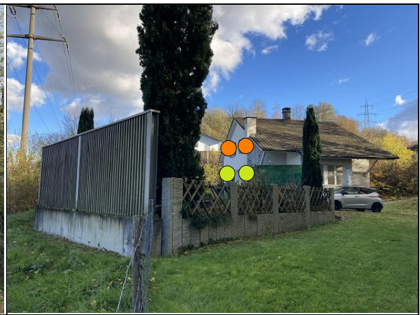
Nordfassade und Westfassade
