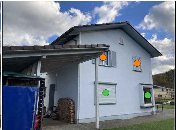
Nordfassade und Westfassade
