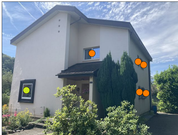
Südostfassade und Nordostfassade
