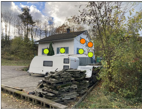
Ostfassade und Nordfassade
