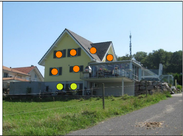
Nordfassade und Westfassade
