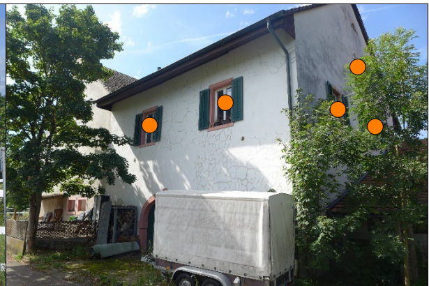
Nordostfassade und Nordwestfassade
