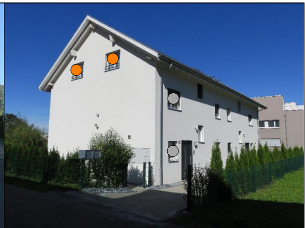
Südfassade (beurteilt) u. Ostfassade (n. beurteilt)
