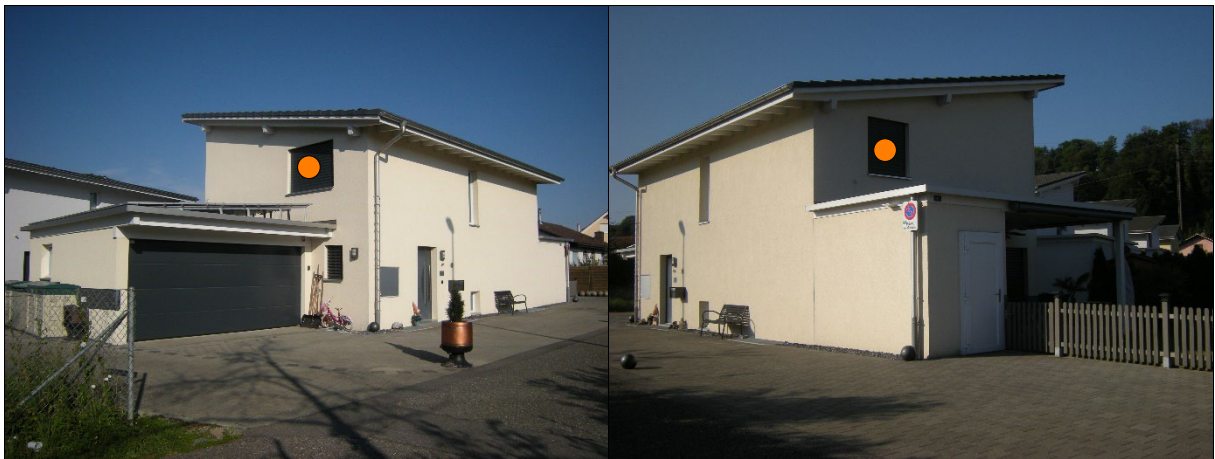
Südostfassade und Nordostfassade
