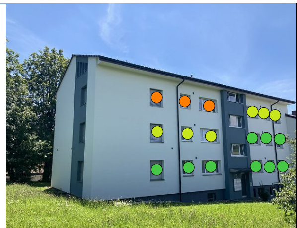
Nordfassade (Nord 1 links, Nord 2 rechts)
