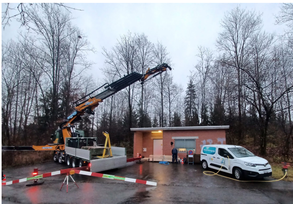
Aufstellung und Vorbereitung für Pumpenaustausch im Grundwasser-Pumpwerk Neumatt
