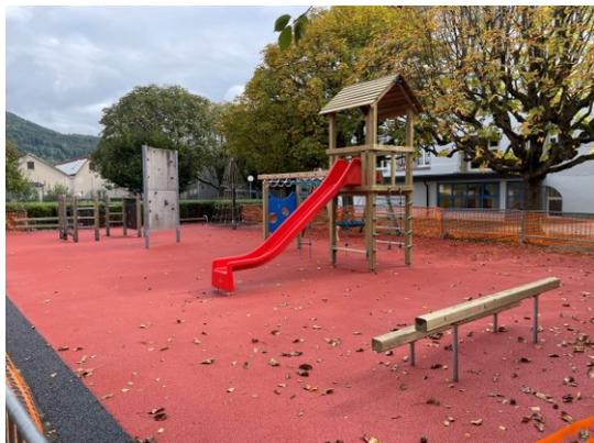
tere Arbeiten wie die Ausdehnung des Fallschutzbereichs aus, da dieser nicht mehr den gängigen Sicherheitsnormen entsprach. Mit den ausgeführten Arbeiten (neuer Spielturm) und Ersatz des Fallschutzes durch gegossenen Fallschutz konnte der Spielplatz Schule Dorf sowohl sicherheitstechnisch als auch optisch deutlich aufgewertet werden.
