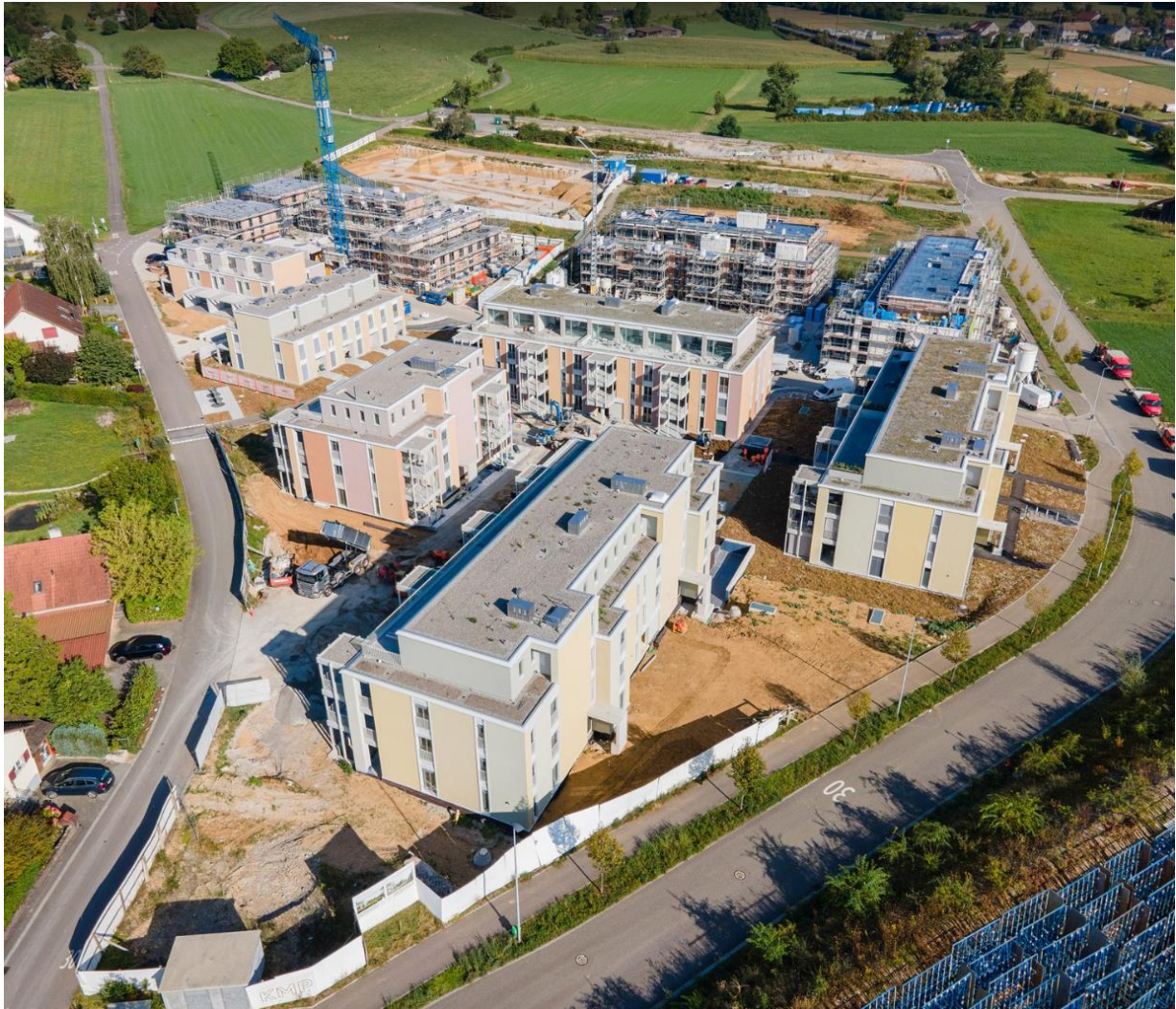
Foto Überbauung "Lammet"
