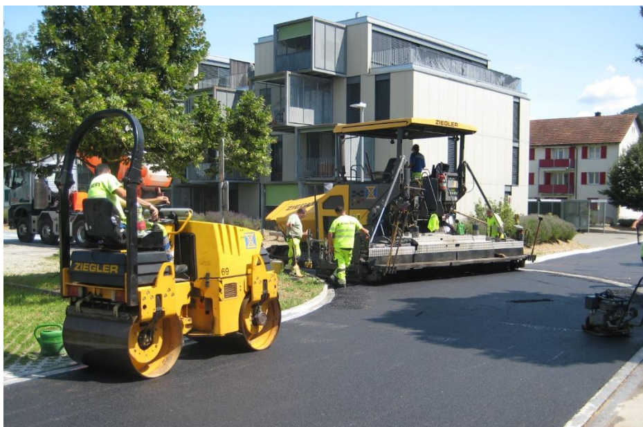
Foto Sanierung Turner- und Sportplatzweg
